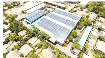
(වහල මත ඉදිවන සූර්ය බල පද්ධති) (Rooftop Solar System)
